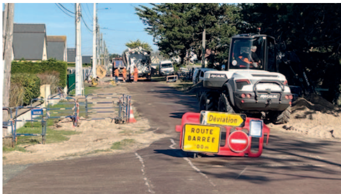
Effacement des réseaux
