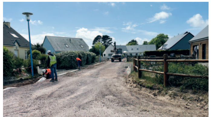
Enrobés lotissement Ermice
