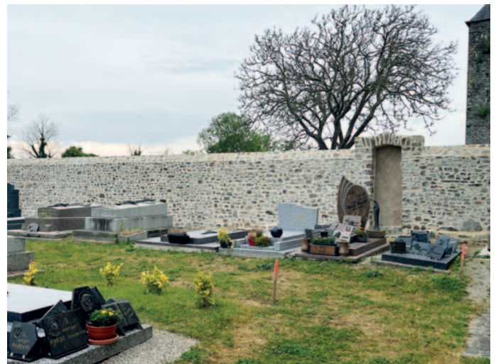
Réparation mur cimetière
